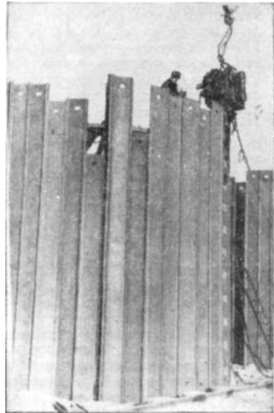
*Шпунтовое ограждение, созданное с помощью вибратора.*
