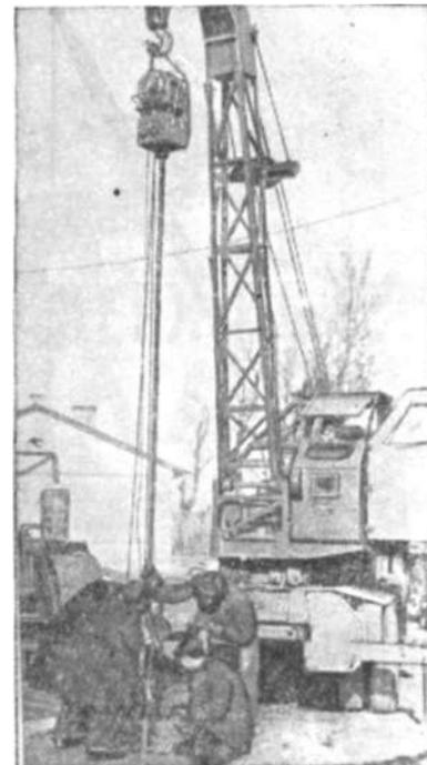
*Вибратор погружает в землю трубу для разведки грунта.*
